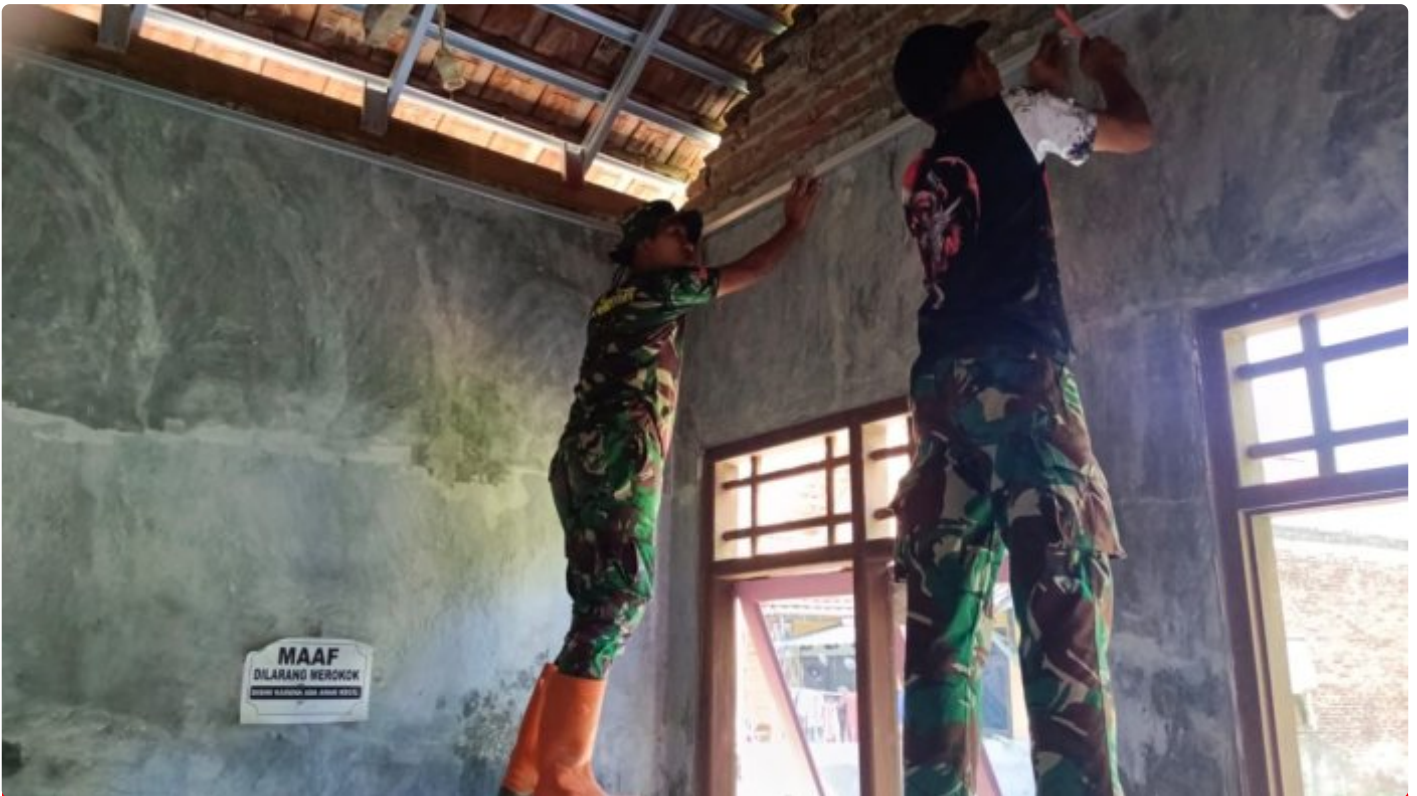
( Foto istimewa ) satgas tmmd pasang kerangka plafon RTLH
