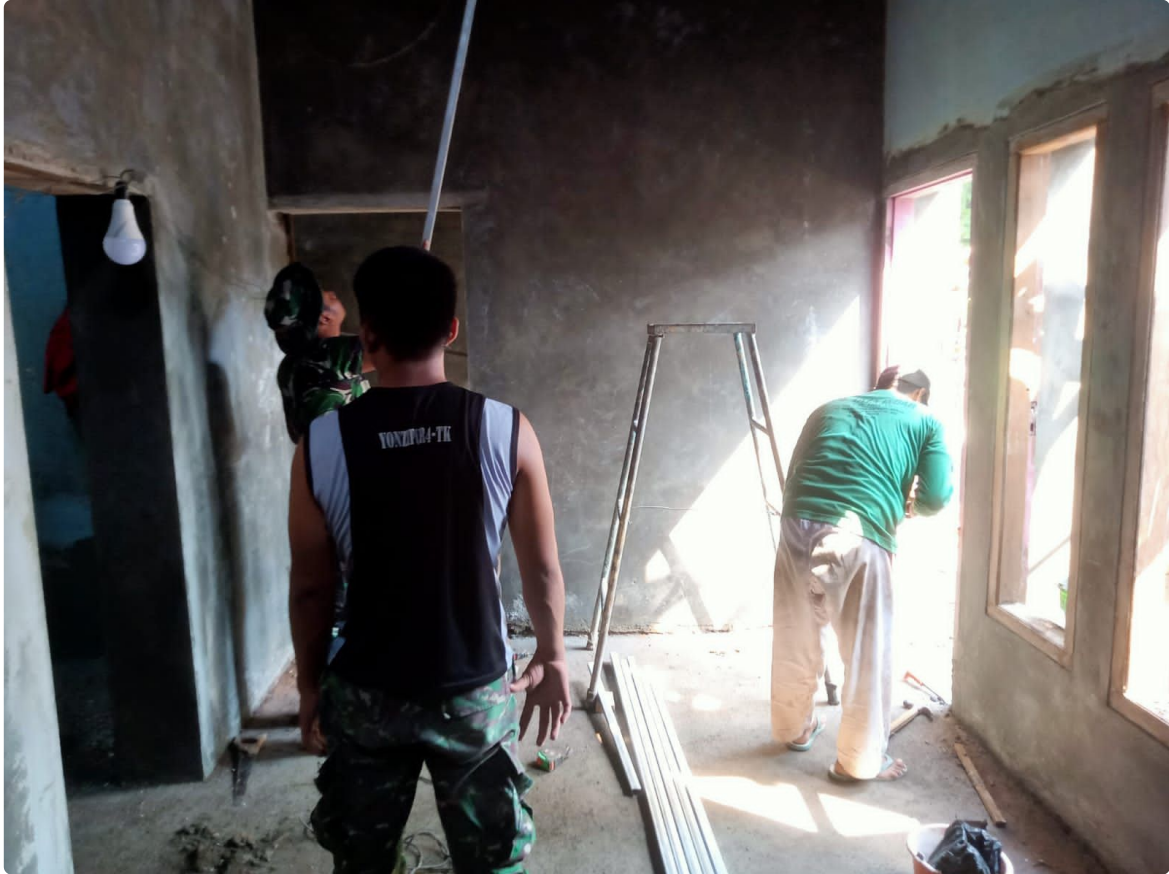
Dan SSK TMMMD 116 Kodim 0722/Kudus Kapten Inf P. Siagian menyampaikan pengerjaan RTLH milik Ibu Sumitrah saat ini sudah pada tahap pemasangan plafon kamar dan juga pembuatan teras rumah.
