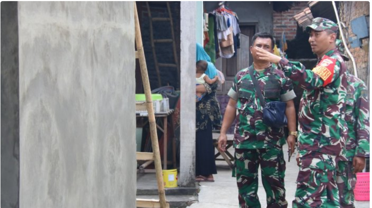
(Foto istimewa ) dansargas tmmd tinjau lokasi RTLH
